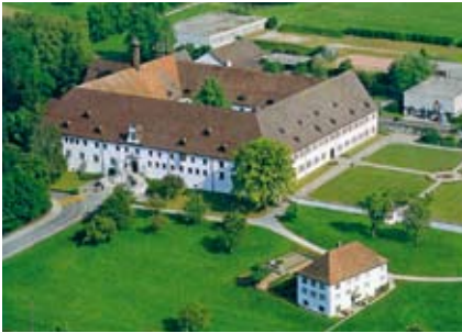
Hochschulgebäude Marienberg Seminarstrasse 27, 9400 Rorschach
